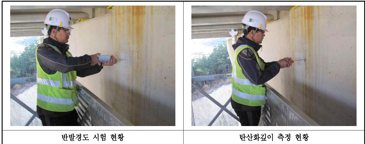
【사진 2.4.1】 콘크리트 내구성조사 현황
