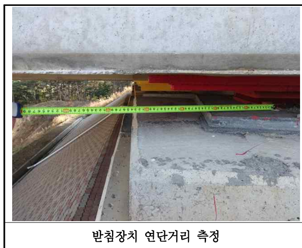
【사진 2.3.14】 교량받침장치 연단거리측정
