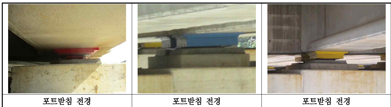
【사진 2.3.35】 교량받침 전경
