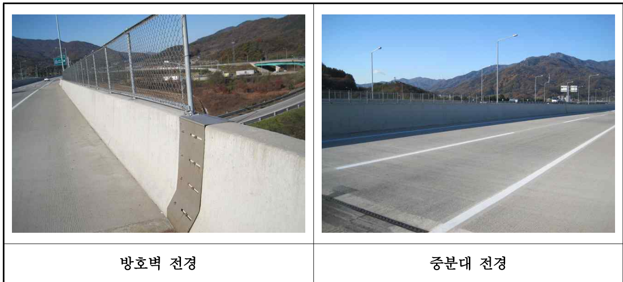
【사진 2.3.23】 방호벽 및 중앙분리대 전경
