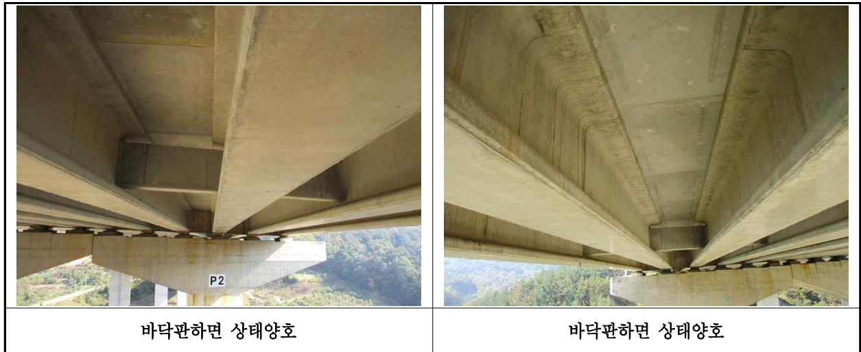
【사진 2.3.26】 바닥판하면 손상현황
