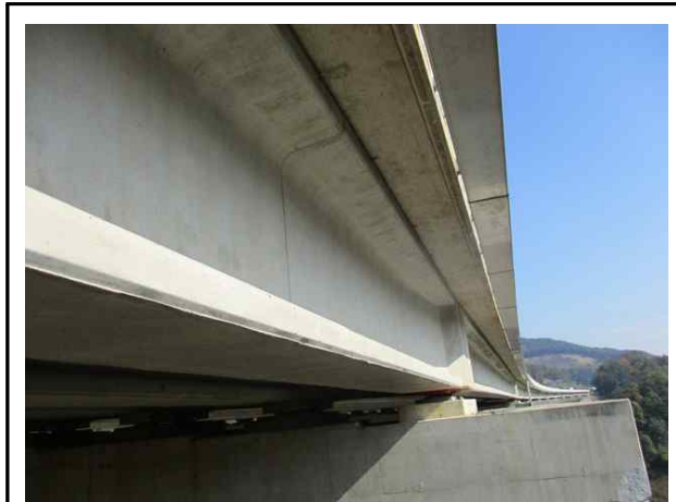
거더 내측 전경
