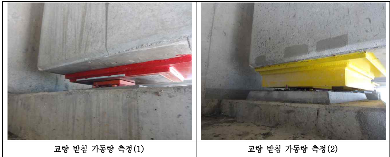
【사진 2.3.38】 교량받침 이동량 측정
