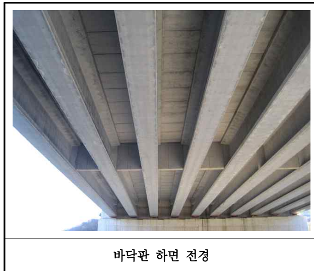
【사진 2.3.2】 바닥판하면 전경
