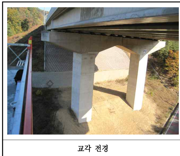
【사진 2.3.10】 교각 전경
