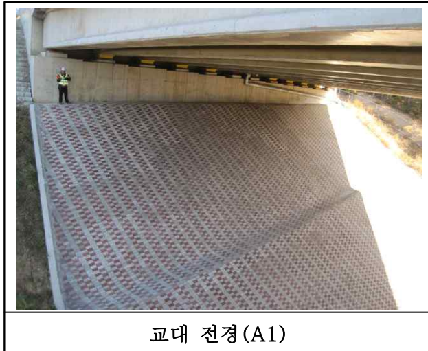
【사진 2.3.31】 교대 전경
