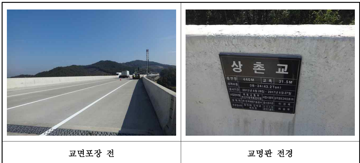
【사진 2.3.42】 교면포장 전경
