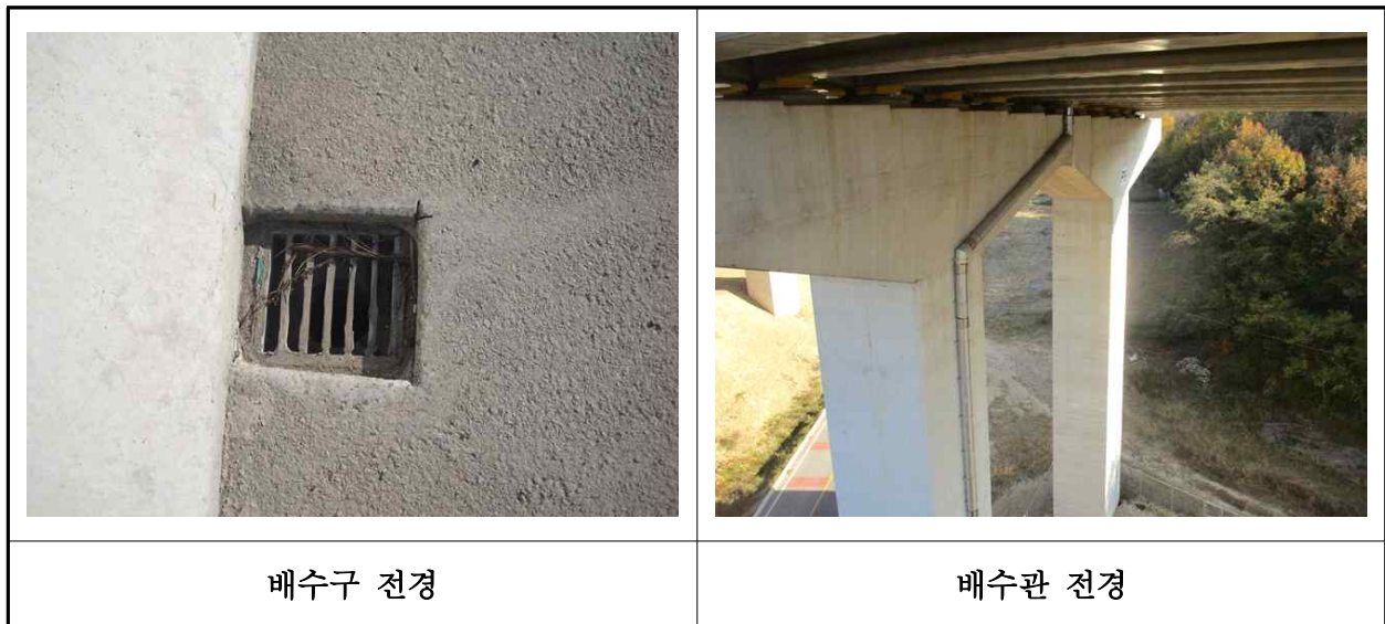
【사진 2.3.21】 배수시설 전경
