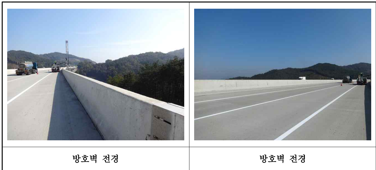
【사진 2.3.46】 방호벽 및 중앙분리대 전경
