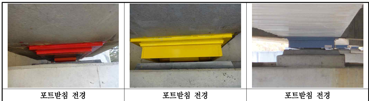
【사진 2.3.12】 교량받침 전경
