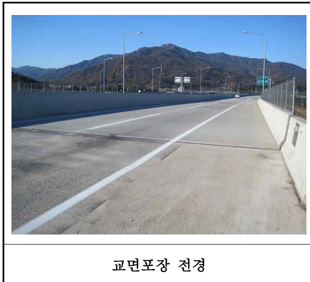
【사진 2.3.19】 교면포장 전경
