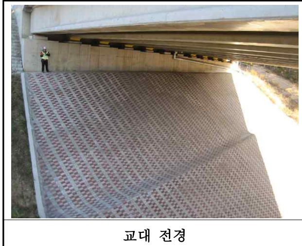
【사진 2.3.8】 교대 전경
