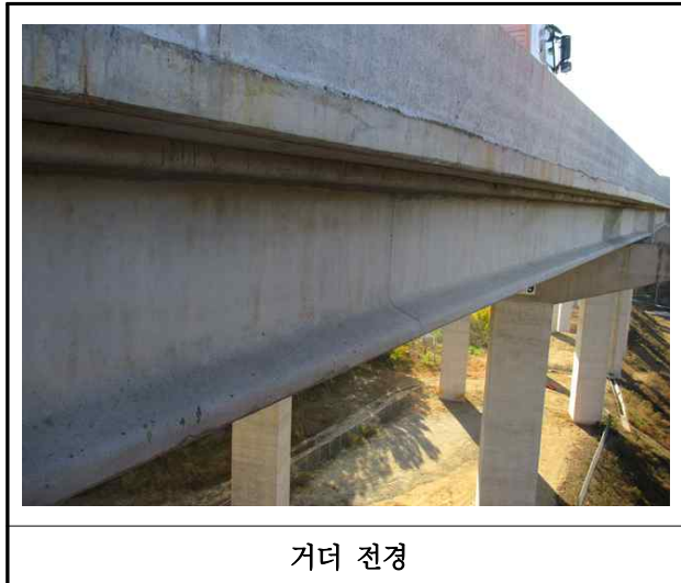
【사진 2.3.4】 거더 전경
