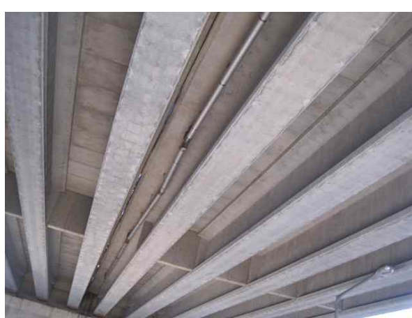
배수시설 상태 양호
