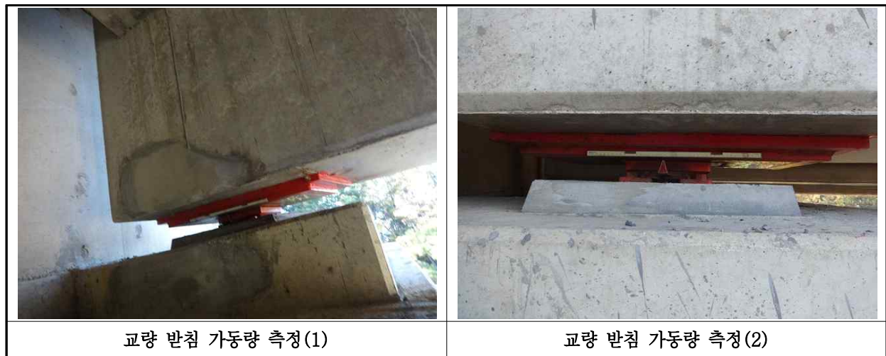
【사진 2.3.15】 교량받침 이동량 측정
